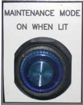
Figure 8 : Voyant lumineux local du mode d'entretien
