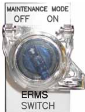
Figure 7 : Interrupteur ERMS local
