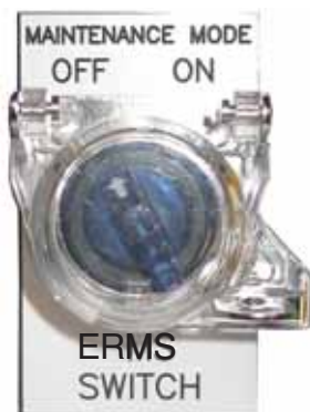
Figure 3 : Interrupteur ERMS local
