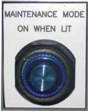
Figura 8: Luz indicadora local de modo de mantenimiento
