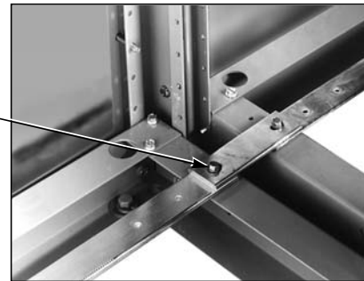
Figure 16 – Raccordement de jonction de la barre-bus de m.à.l.t. de la série 2
