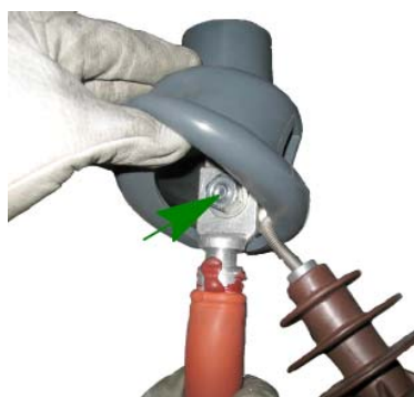
Conectar cable a fase L1 Par de apriete 50Nm.
