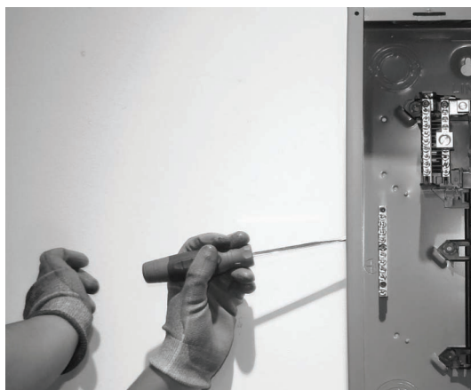
FIG. 1 : Knockout Removal / Extracción de los discos removibles / Retrait de débouchure
