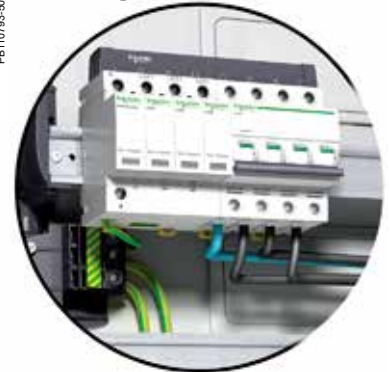
Surge arrester iPRD 3P+N + iC60N 3P+N
