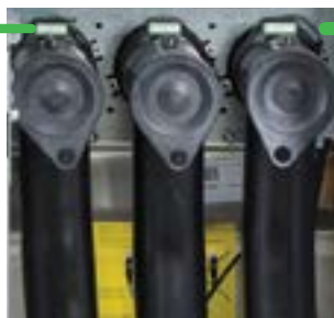
TH110 встановлений на кінцевій частині кабелю
